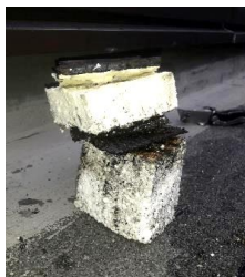
Afb 33. Aanzicht opbouw dak.
