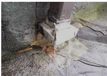
Afb 16. Aanzicht met kit afgedichte aansluiting baluster en dakbedekking.
