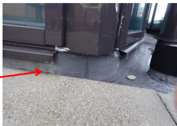
Afb 15. Aanzicht van de craquelé in de coating.
