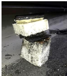
Afb 33. Aanzicht opbouw dak.
