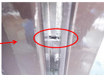
Afb 19. Voorbeeld van één van de openingen in de dakbedekking rondom de montageplaat afscheiding.
