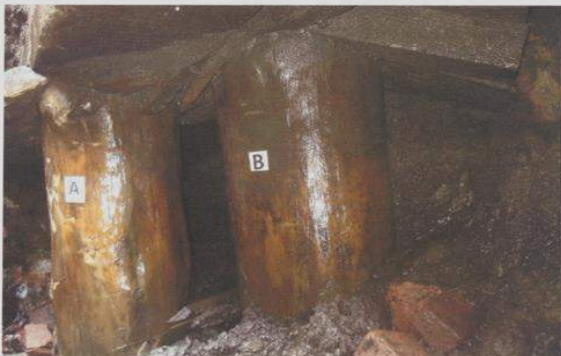
Langshout L1, schuifhout S1, kesp 1, paal A en B.
