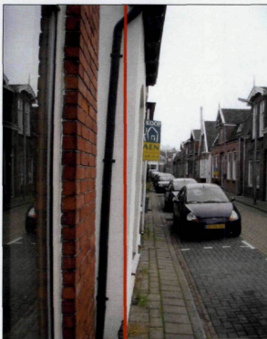
Foto 13: Duidelijk de scheefstand in beeld bij de voorgevel van nr. 42.
