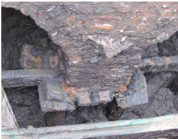
Ingezoomde foto inspectieput van bovenaf
