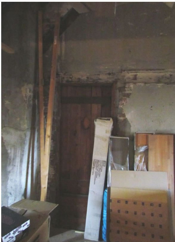
Branddeur zolderverdieping tussen 36 en 38.
