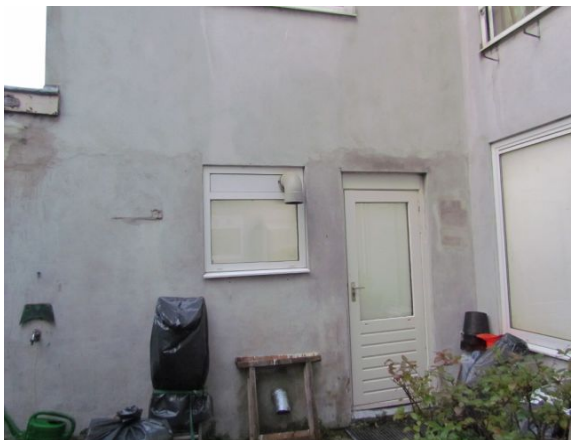
Zijgevel uitbouw begane grond
