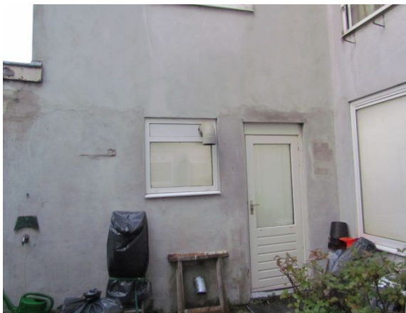
Zijgevel uitbouw begane grond
