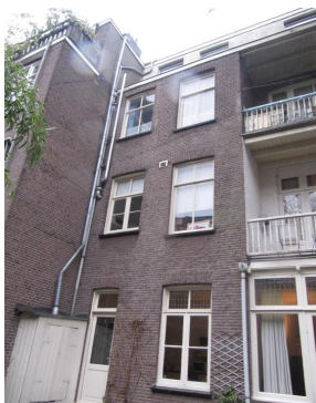
Foto 2: Overzicht ged. achtergevel
